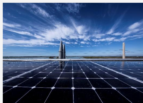
ภาพที่ 5 ติดตั้งแผงโซลาร์เซลล์บนอาคาร
