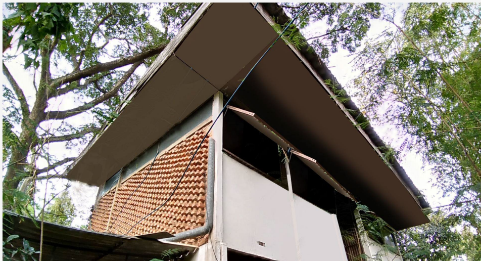
รูปที่ 10 แสดงตัวอย่างรูปแบบหลังคาเพื่อการระบายน้ำที่ดี
