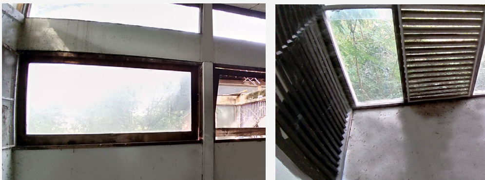
รูปที่ 7 แสดงลักษณะของบานหน้าต่างบานกระทุ้งขนาดใหญ่ พร้อมเกล็ดระบายอากาศ
