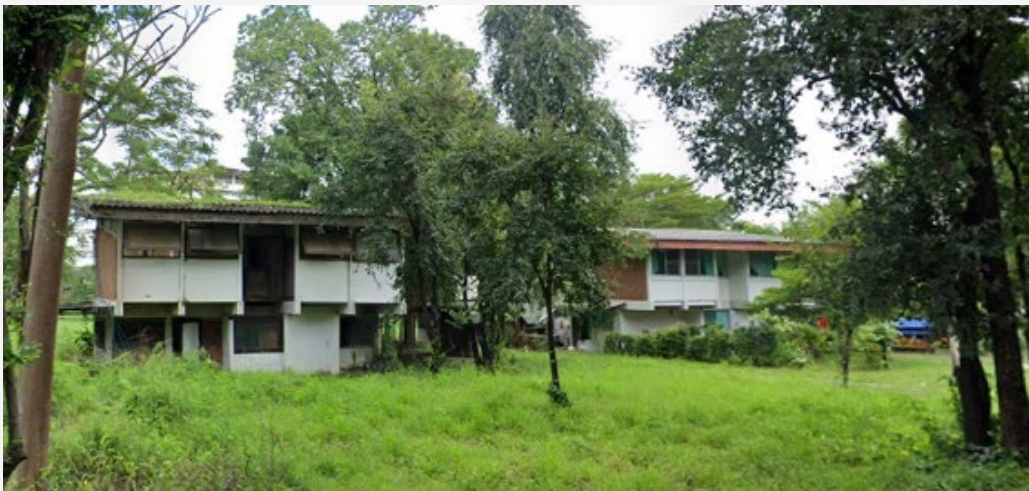
รูปที่ 3 สภาพปัจจุบันบ้านพักข้าราชการทั้ง 2 อาคาร
